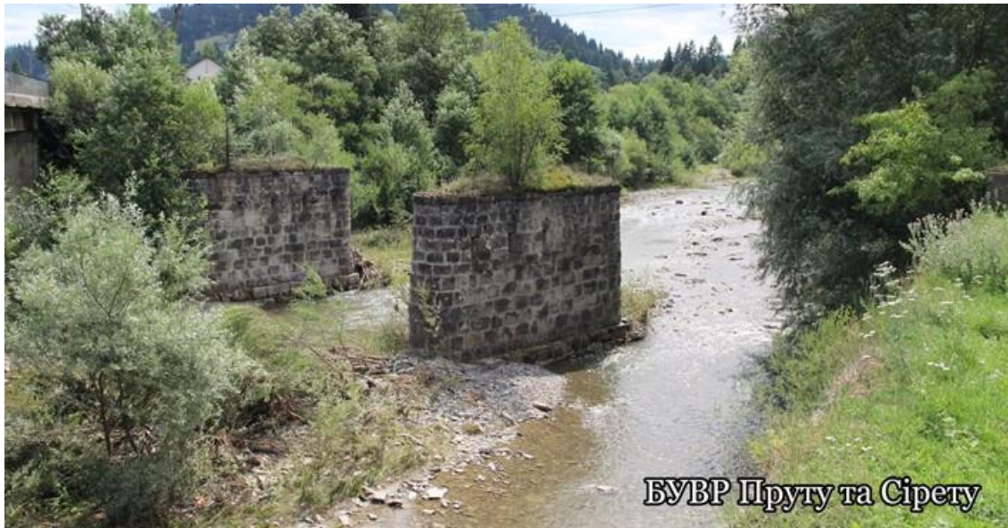
Рисунок 3.14. Старі мостові опори в р. Путила, с. Дихтинець, Путильська ТГ
